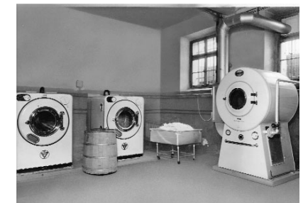
Waschküche mit vollautomatischen Maschinen
